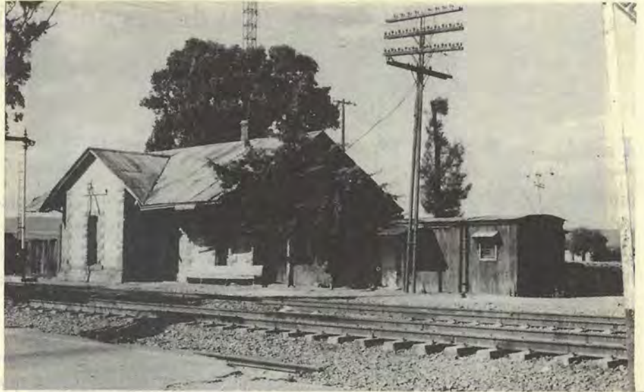
Antigua estación en la Griega municipio del Marqués, Qro. Desmantelada en 1993. Por acuerdo federal deberá ser reconstruída en la localidad.
