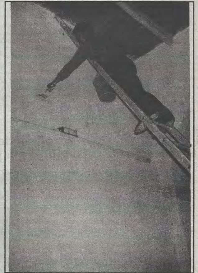
La remodelación en instalaciones de la cárcel municipal
