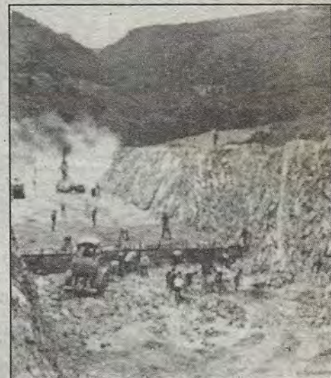
Presa del Batán
