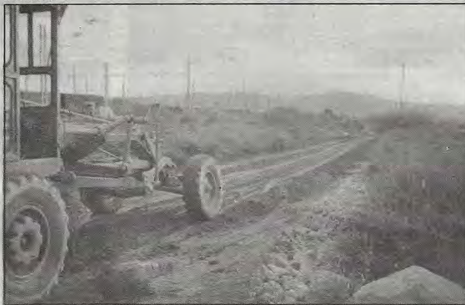
Avanzan las obras de construcción del camino de acceso a El Pedregal.
