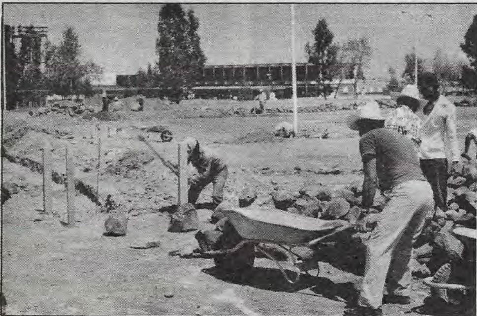
El lunes 18 de abril comenzaron los trabajos de construcción de cuatro canchas de basquetbol, a un costado del Centro Cultural y Convenciones de esta ciudad (Cecuco). Su costo aproximado será de 160 mil nuevos pesos, una inversión cien por ciento municipal. Asimismo, el director municipal de Obras Públicas,
