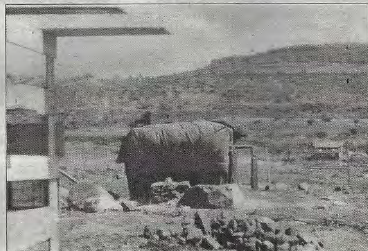
"Viviendas" levantadas en San Pedrito Peñuelas.
