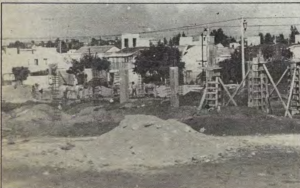
Inicia la obra en el campo de futbol
