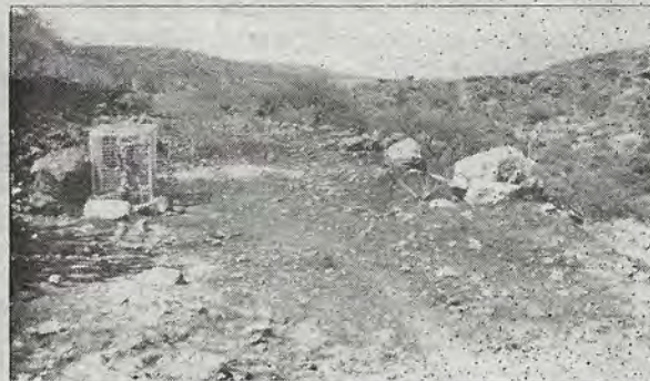
La brecha que abrió la CEA. A la izquierda se observa un "respiradero" de la línea hidráulica.
