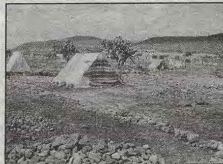
Inicios de construcción.
