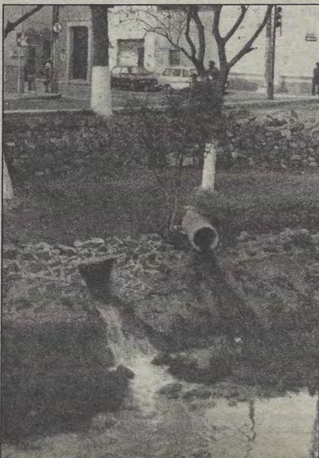
Descarga de aguas negras al río: más contaminación.
