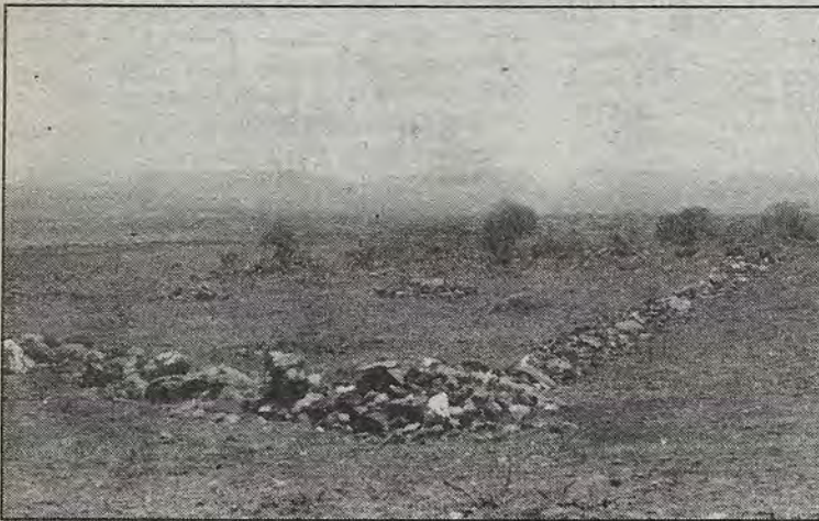
Una esquina en el terreno trazado ya con 372 solares en El Mirador.
