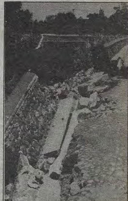
El puente de la vía en Calesa.
