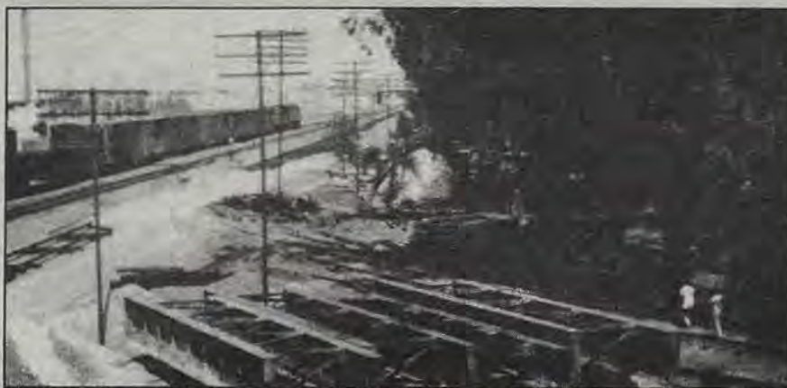
Avanzan las obras de acondicionamiento de la estación ferroviaria local.
