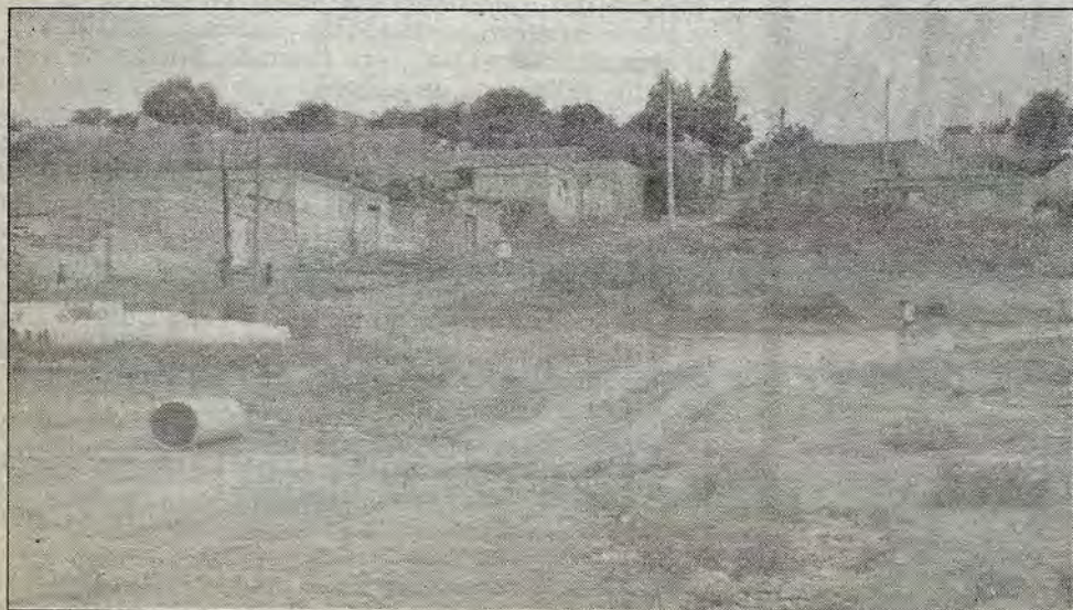
Sin drenaje, sin pavimento...
