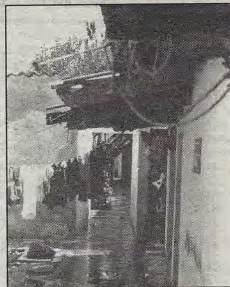
Techos de lámina de asbesto
