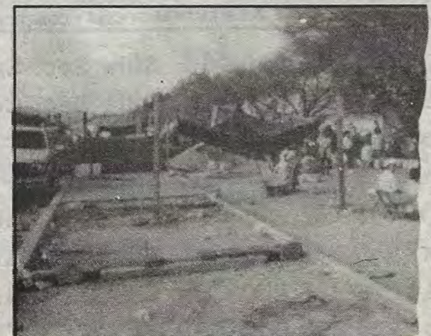
Construcción de locales comerciales
