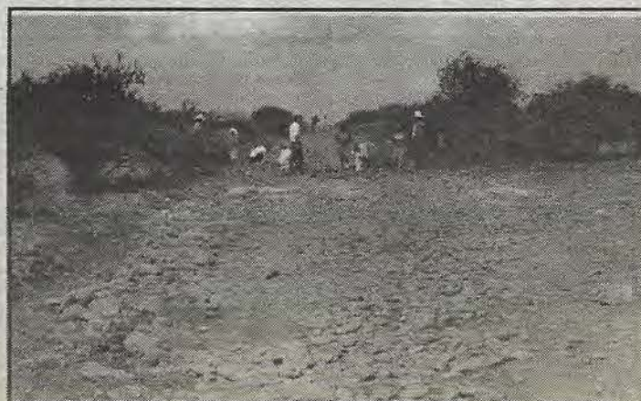
Avanzan los trabajos de urbanización.
