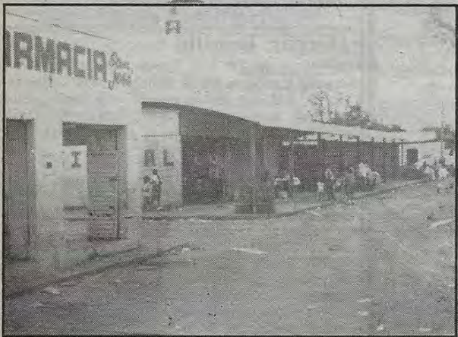
Remodelación en el mercado municipal
